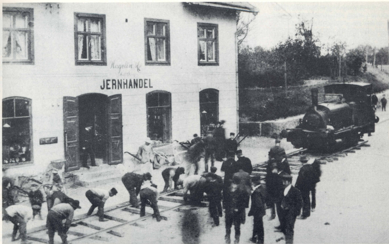
Den danska entreprenadfirman arbetslok "Aage" forslades på detta sätt genom gatorna i Mjölby till Sörby. Samling: Mjölby kommun, kulturnämndens arkiv.
