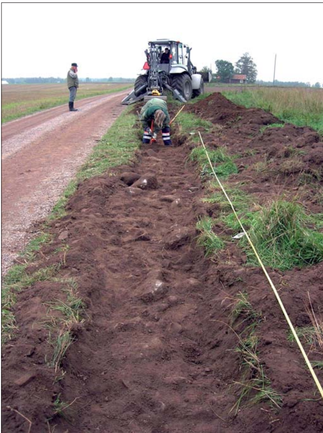
Figur 40. Område 28. Schaktning utmed den befintliga telekabeln, som tidigare lagts ned rakt genom stensättningen A3. Foto mot V.
