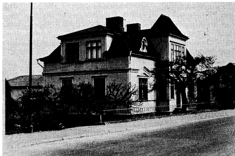
Bild 11. Villa från sekelskiftet. Björkeberga vid Mjölbyvägen är byggd 1909, och renoverades 1976. Den fantasifulle blandningen av puts- och träarkitektur har på ett förtjänstfullt sätt bibehållits under drygt 70 år. Foto Östergötlands Läns Museum 1978
