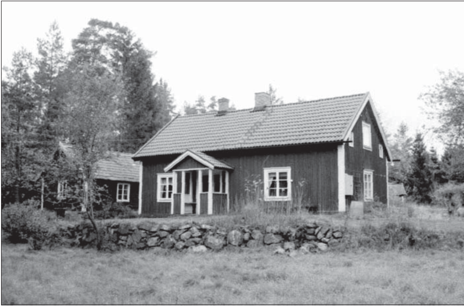
Stuga och bod från sydväst, Höghult 1:9 (tidigare 1:5)
