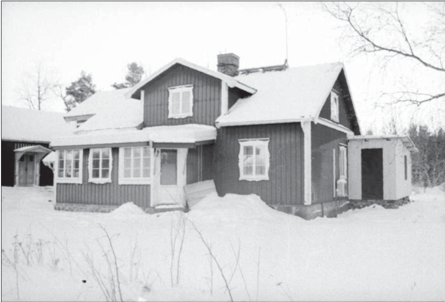
Mangårdsbyggnad från nordöst, Frebol 1:6
