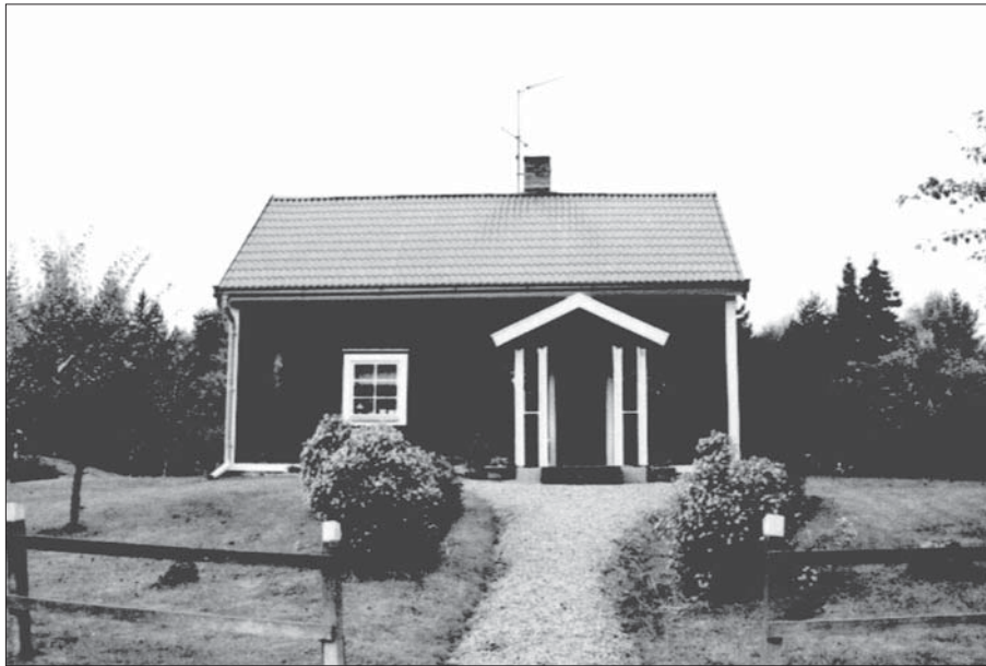
Mangårdsbyggnad från öst, Boeryd 1:8
