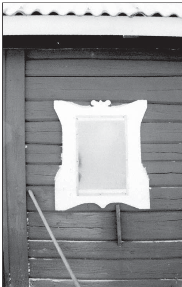
Fönsteromfattning på stall, Frebol 1:7
