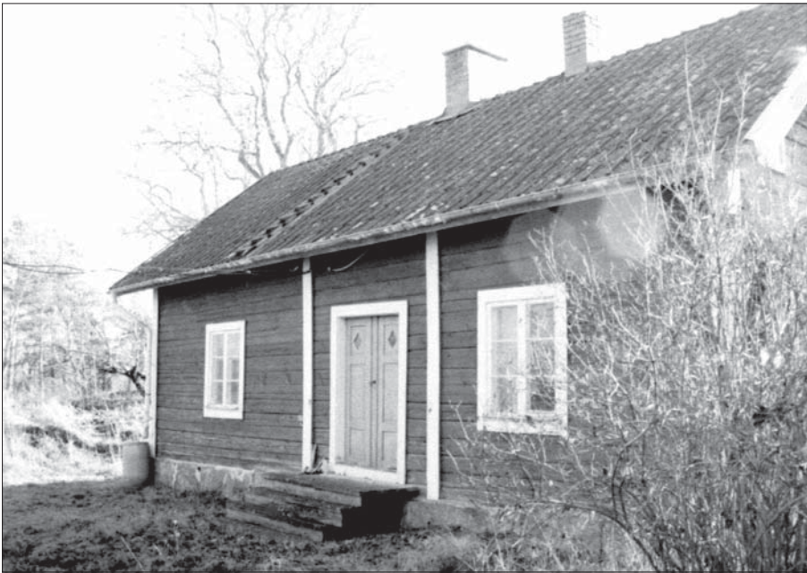
Mangårdsbyggnad från nordväst, Pelarebo 2:3/Håletorp
