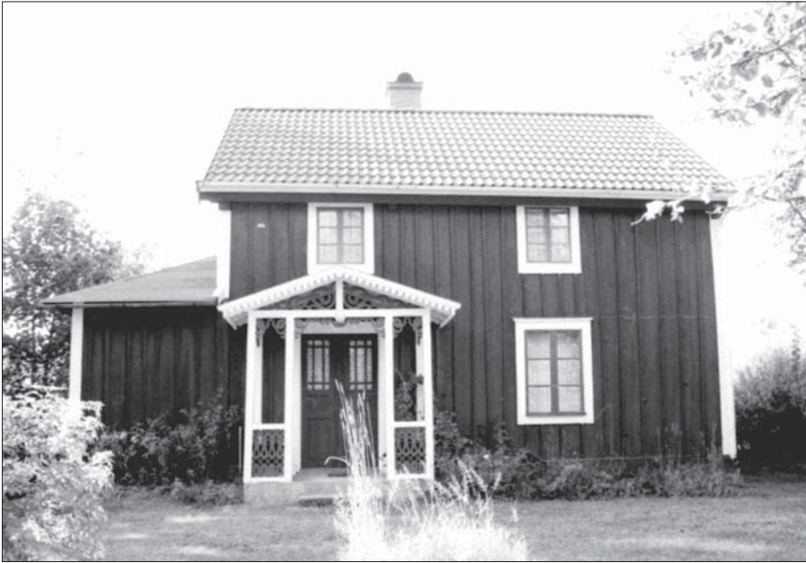
Mangårdsbyggnad från nordöst, Boeryd 1:9
