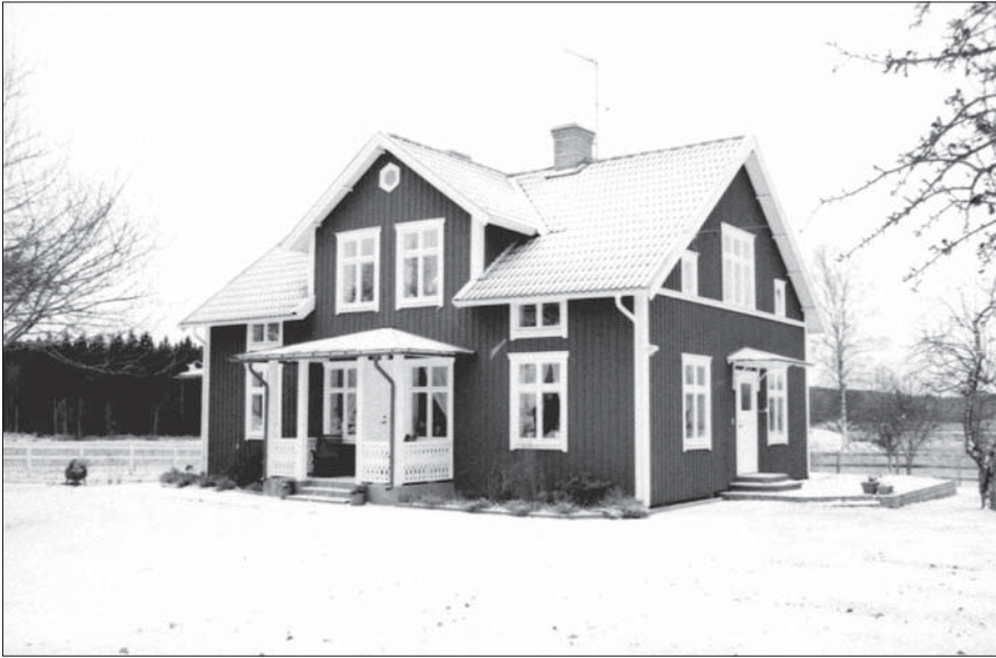
Mangårdsbyggnad från norr, Kushult 1:3
