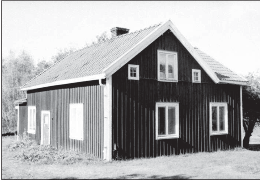
Mangårdsbyggnad från sydöst, Boeryd 1:5
