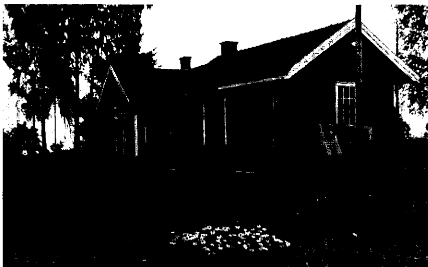
Arneberga station, håll- och lastplats 1950-58, låg ensamt placerad ute på slätten utan någon koncentration av bebyggelse i närheten. Arneberga var, trots detta, sannolikt en av de livaktigaste mellanstationerna. I anslutning till sta-
