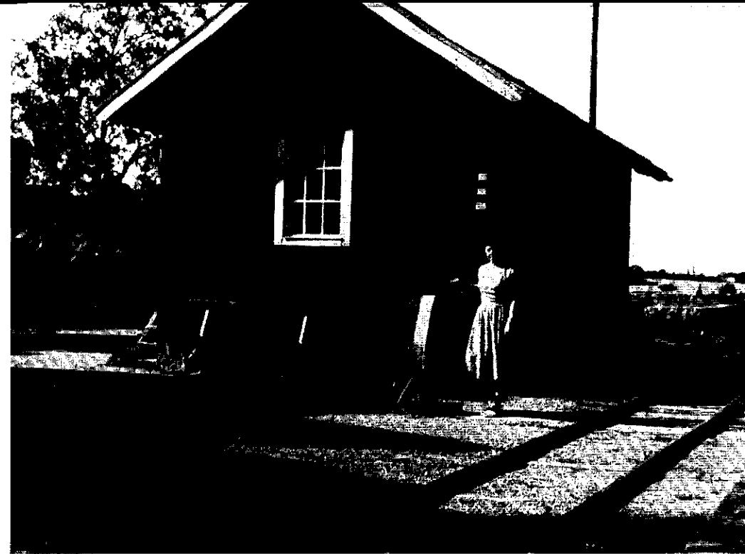
Väversunda station. Platsvakt Karin Johansson står beredd att fälla bommarna för avgående rälsbuss mot Vadstena. Med vevapparaten manövrerades tre bommar samtidigt; två över riksvägen samt en över vägen mot Väversunda kyrka, som anslöt till riksvägen intill järnvägs-korsningen. Foto sommaren 1958 av Hans Lindström.
