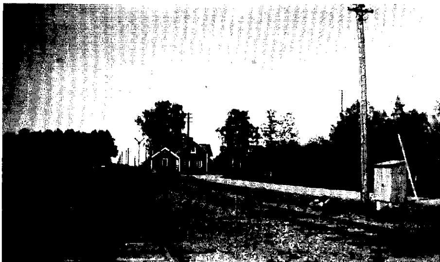
Vy av Arneberga station från söder. Åt söder omgavs linjen in till Arneberga station av industrispår på ömse sidor. Betelevatorn var placerad till vänster strax bakom bildens fotograf, och ett av de långa utdragsspåren för betvagnar syns längst ut till vänster. Spåret som går ut i bildens högerkant fortsätter ytterligare en kort sträcka bort till Centralföreningens spannmålssilo. Foto: Einar Pettersson.
