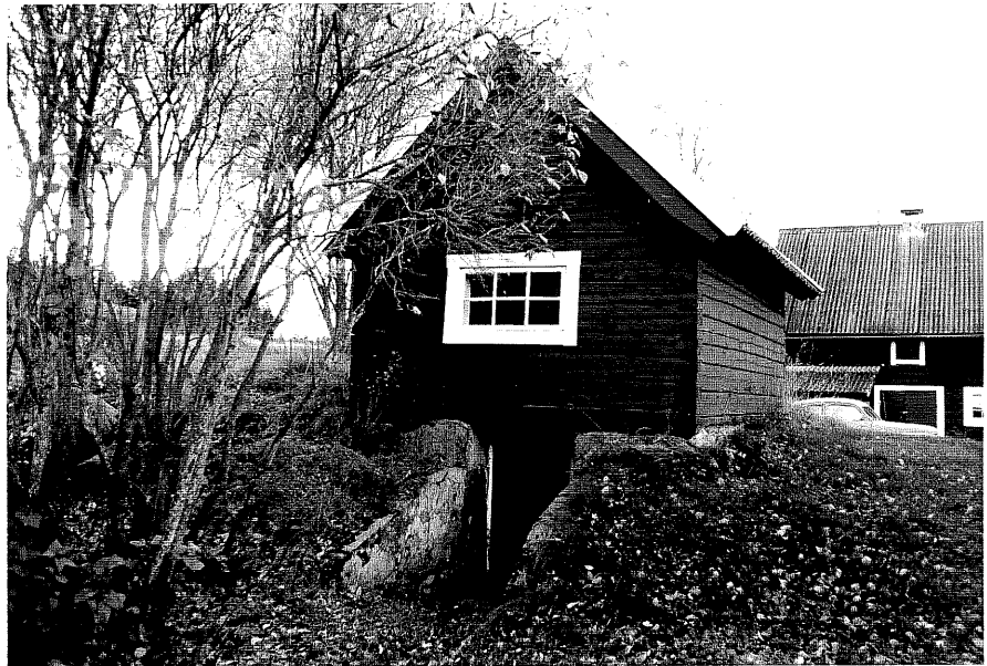
Neg. nr. T 01:20 Källarbod från NO
