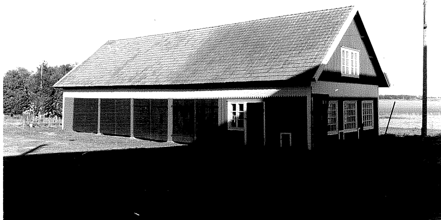
Neg nr ÖKM 11:04 Hönshus, garage från SV byggnad c
