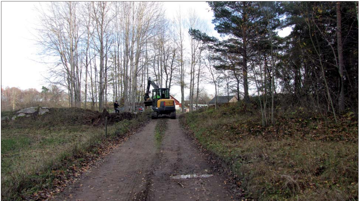
Figur 21. Översikt över Ödeshög 232 och Strûpegatan med Maria Sjöquist och grävmaskin. Mot öster.
