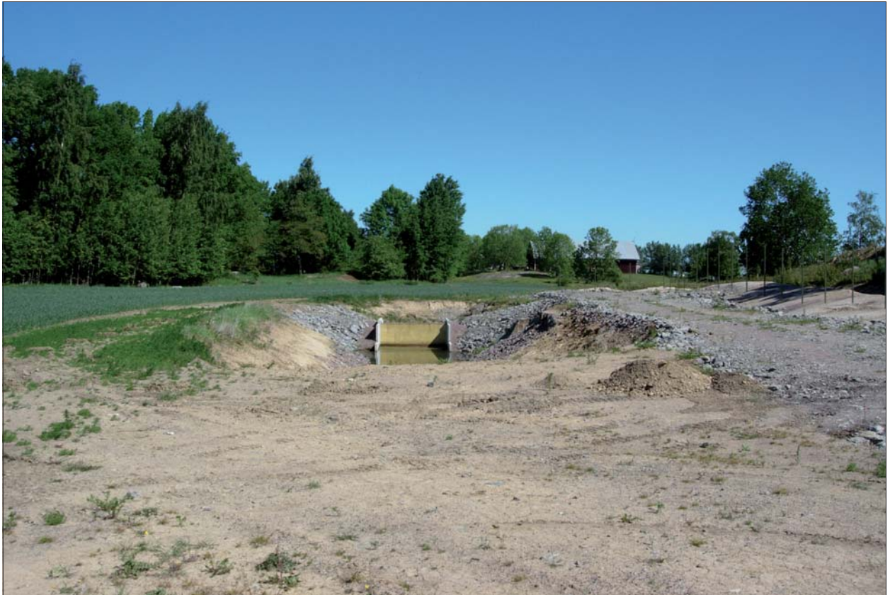
Figur 3 och 4. Nyanlagt dike och transportväg, väster om den centrala hagmarken inom fastigheterna Åby 16:2 och 16:3. Diket och transportvägen hade anlagts kort före den arkeologiska utredningen. Mot öster respektive norr. Foto: Östergötlands museum.
