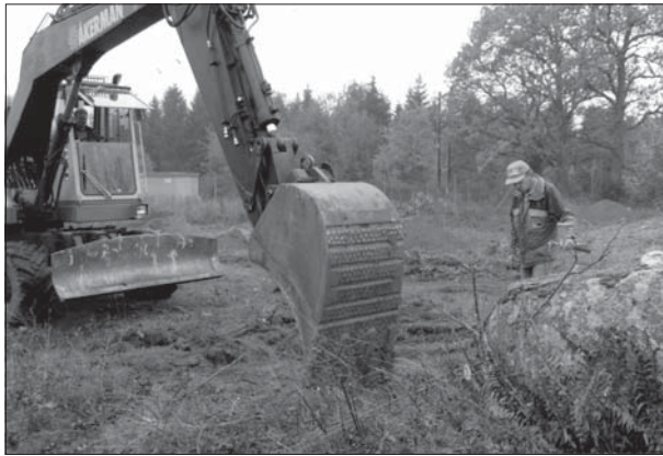
Figur 7. Avtorvning med grävmaskin.
