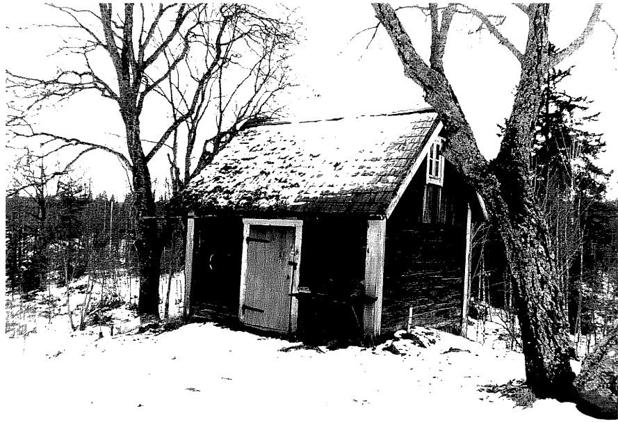
Neg. nr. T 12:34 Källarbod från NO
