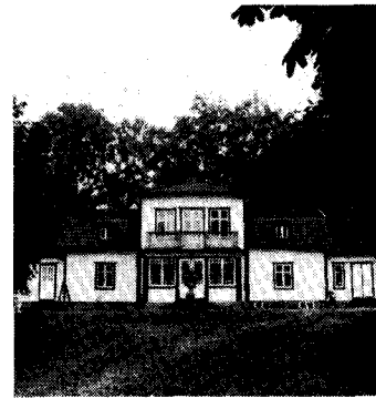
Mangårdsbyggnaden till ryttmästarebostället Stora Lund
