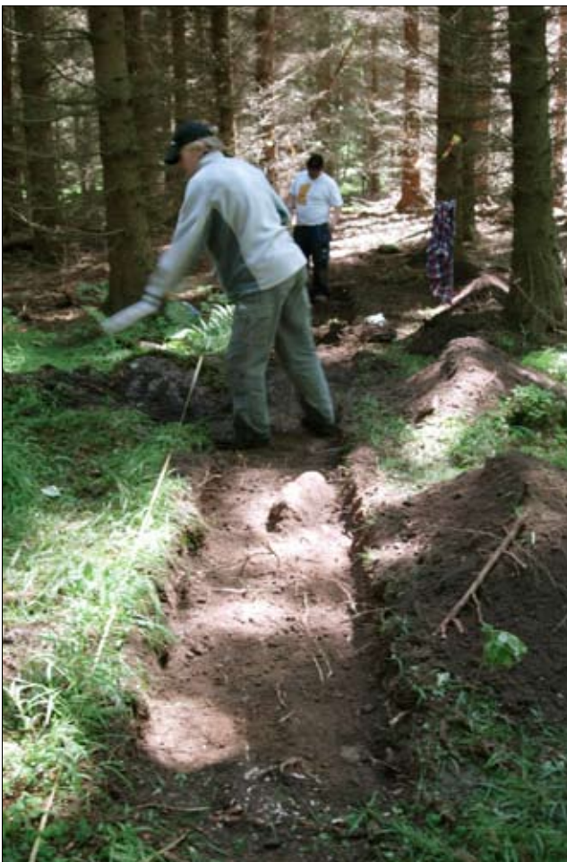
Fig 9. Undersökning av provschaktet vid område A. Foto Clas Ternström.
