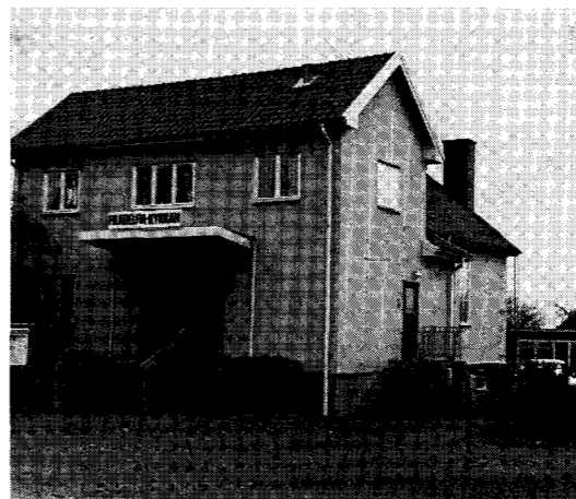
Filadelfiakyrkan (nedan) inköptes 1958 efter att under många år ha varit frälsningsarméns lokal. 1962 renoverades den grundligt och innehåller nu lokaler av skilda slag för församlingens verksamhet.
