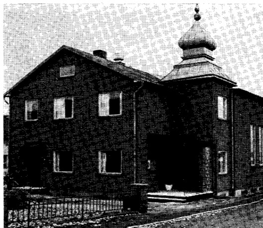
Baptistkyrkan (ovan) uppfördes 1910 och fick då namnet Ebeneserkapellet. Senare ändrades det till Baptistkyrkan. I början av 1960-talet genomgick kyrkan en rätt omfattande restaurering, då bl. a. ungdoms- och serveringslokaler iordningställdes i källarplanet.
