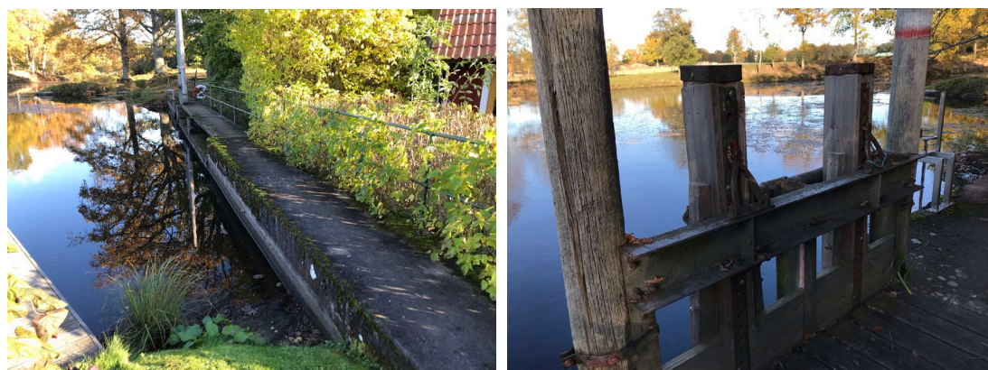
Figur 30. Bilden till vänster visar dammvallen till nedre delen av Orrnäsån. Bilden till höger den visar dammlucka i trä som finns i dammvallen. Foto: Annelie Claësson.
