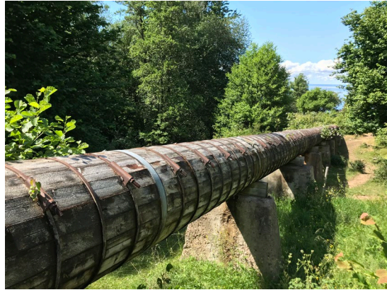
Figur 23. Bilden till vänster visar Orrnäs vattenkraftverk. Bilden till höger visar trätuben som leder vatten från dammen vid Orrnäs till kraftverket vid Vättern. Foto: Annelie Claësson.
