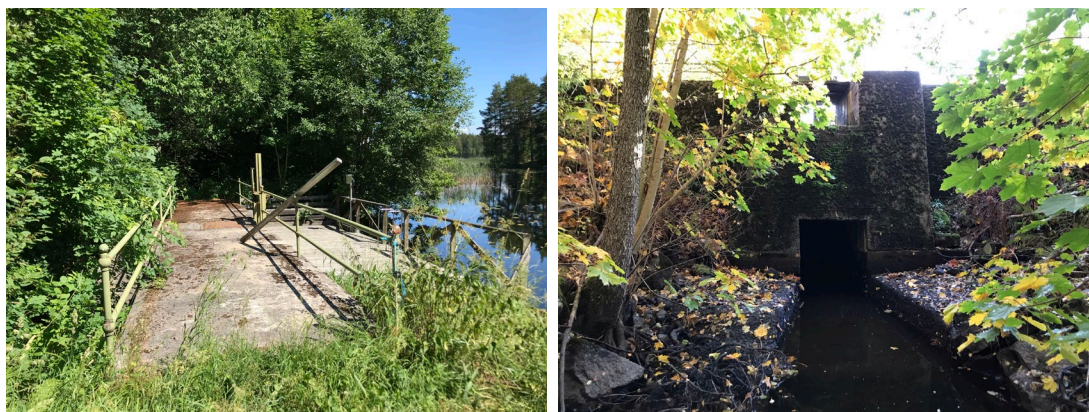
Figur 8. Bilden till vänster visar Visjöns regleringsdamm med byggår 1919. Till höger syns trädäcket och den sentida dammvallen. Bilden till höger visar överfallskrönet och bottenutskovet till Visjöns regleringsdamm. Foto: Annelie Claësson.
