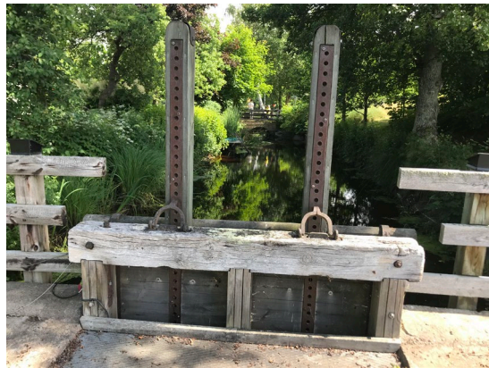
Figur 24. Bilden till vänster visar intagskanalen till trätuben vid dammen vid Orrnäs. Bilden till höger visar dammluckan i trä vid tubintaget. Foto: Annelie Claësson.
