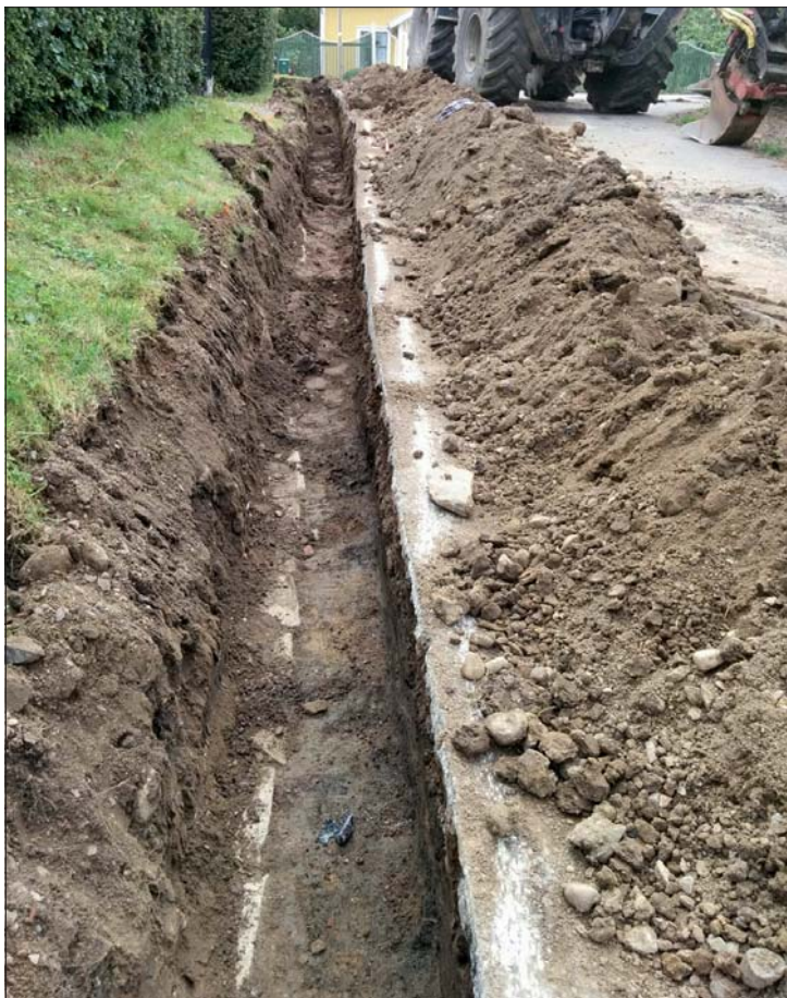
Figur 5. Kulturlagret i schaktets högra del med störningen till vänster. Längre upp i schaktet skymtar stenläggningen. Mot söder. Foto: A-C Feldt.
