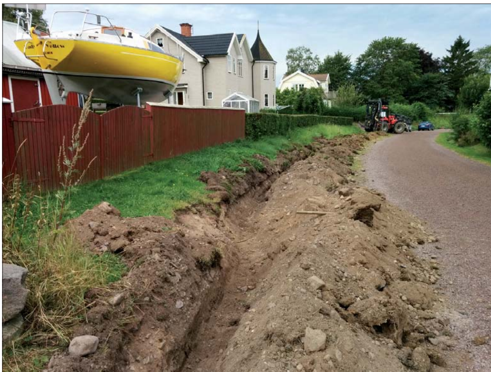
Figur 6. Schaktning längs Lastbergsvägen/gamla banvallen. Mot öster. Foto: A-C Feldt.
