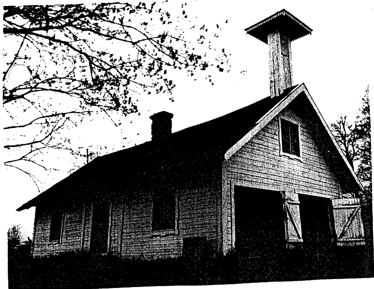
Aby Västergård 5:1 Visthus-snickarbod från NO. Foto ÖLM
