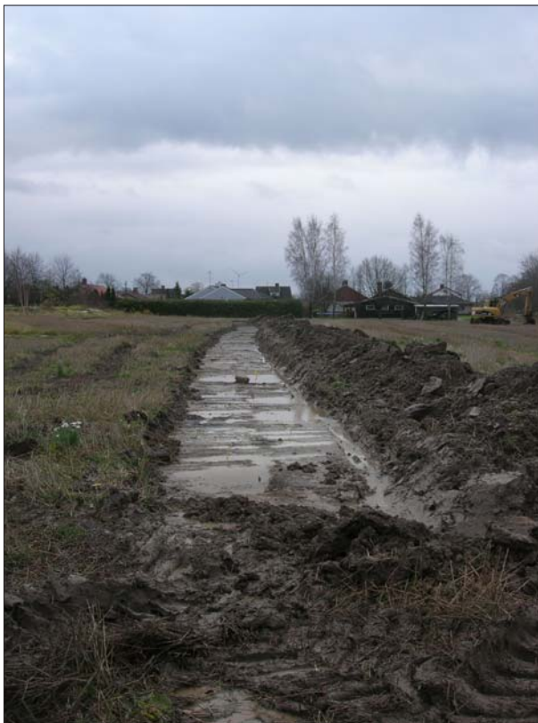
Figur 7. Schakt 1 från norr, efter dränering. Foto: Erika Räf, ÖLM.
