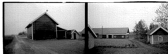
Maskin-hall, förråd 4 & 5, Ladugård, hönshus 6 & 7 från S
