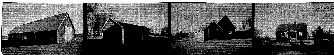
Ladugård från NV 6. Garage från SV 7. Garage n. från Ö 8. Bostadshus från V 9.
