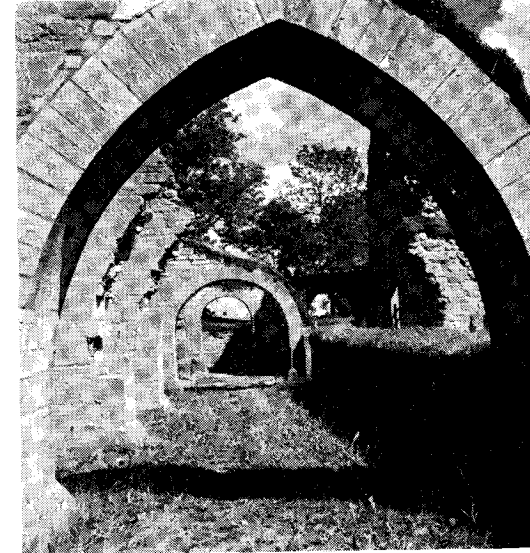
Klosterkyrkans södra sidoskepp med svagt spetsade valvbågar; i bakgrunden korets rent romanska.
