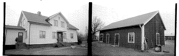
Mangårdsb. NV 1. Uthus från SO 2
