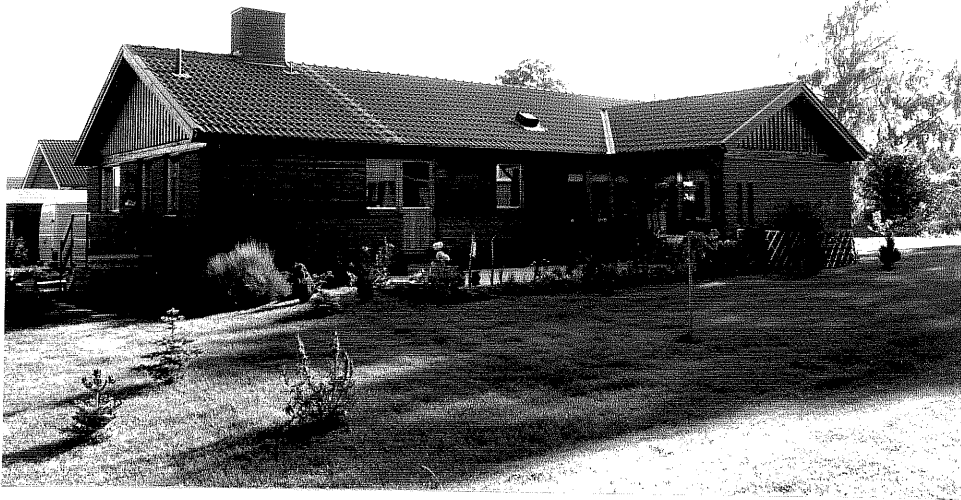
Neg. nr. V.T 05:19 Villan mot väster
