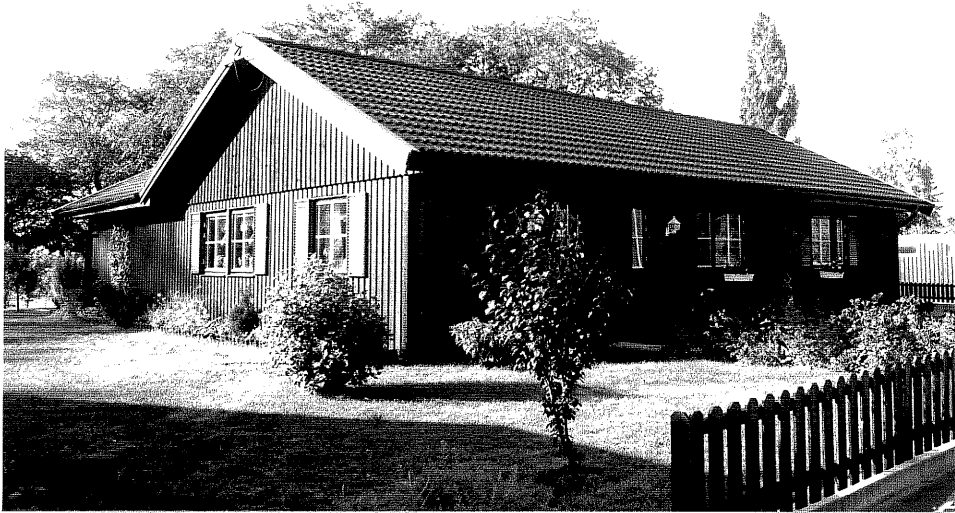
Neg. nr. V.T 05:17 Villan mot norr
