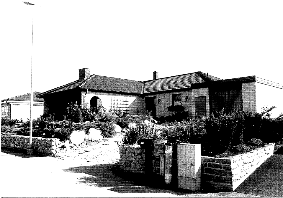
Neg. nr. V.T 05:25 Villan mot sydväst
