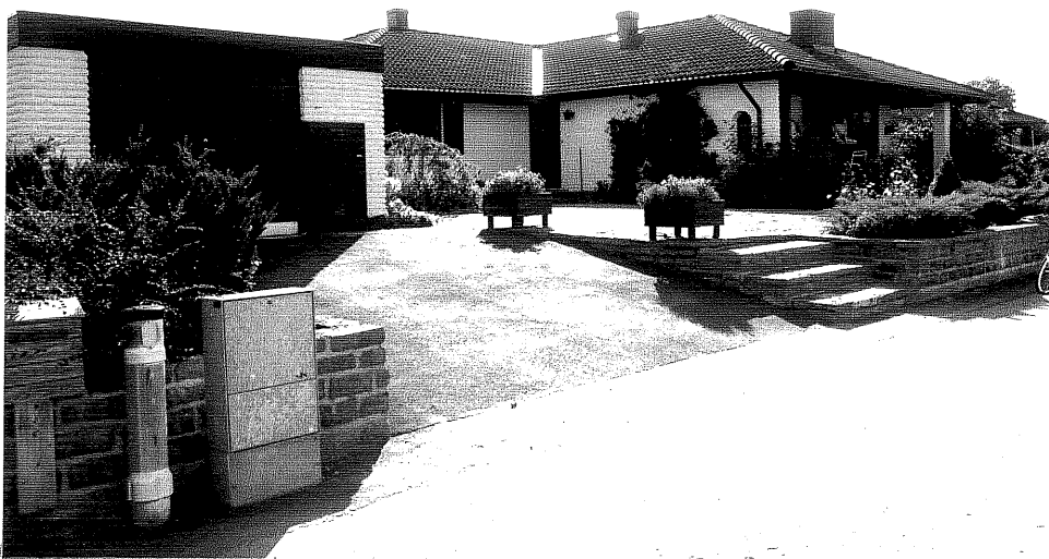
Neg. nr. V.T 05:26 Villan mot väster
