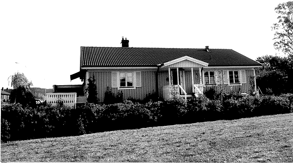
Neg. nr. V.T 05:22 Villan mot sydväst
