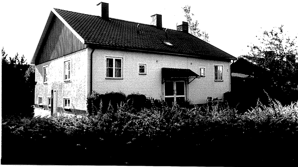
Neg. nr. V.T 02:36 Fastighet mot norr
