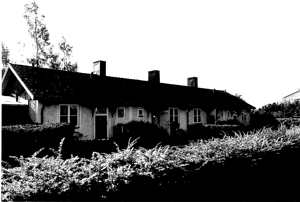
Neg. nr. V.T 02:35 Fastighet mot norr
