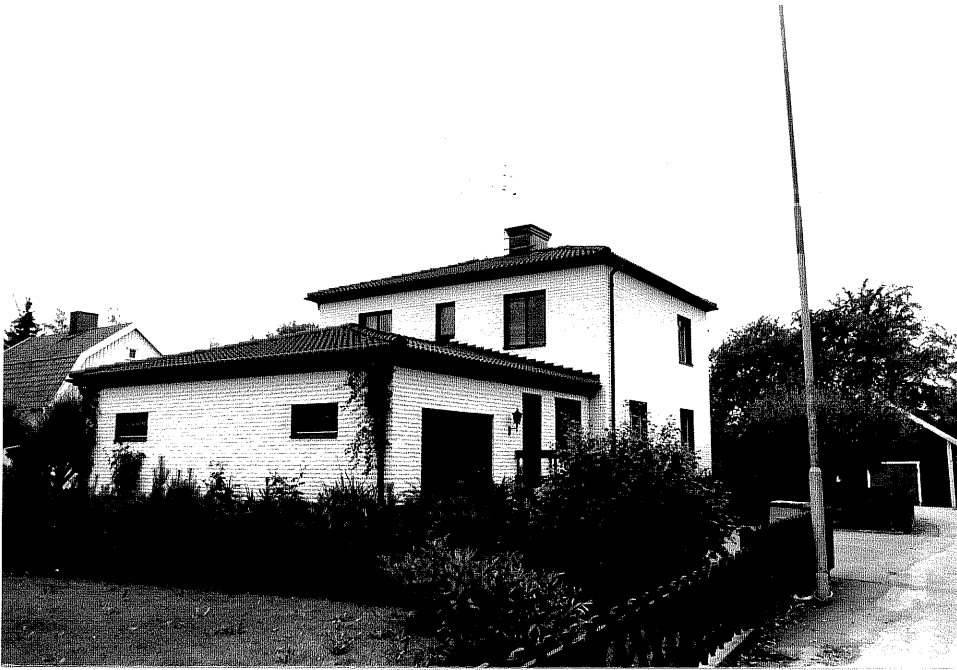
Neg. nr. V.T 07:4 Bostadshus mot norr
