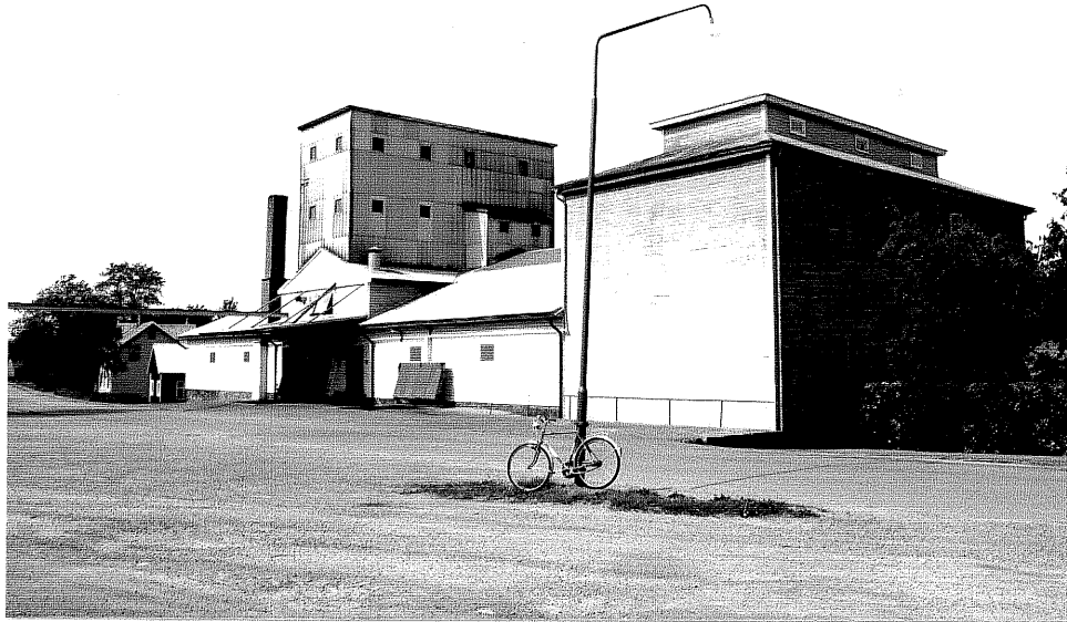
Neg. nr. V.T 04:1 Magasin och tork mot öster
