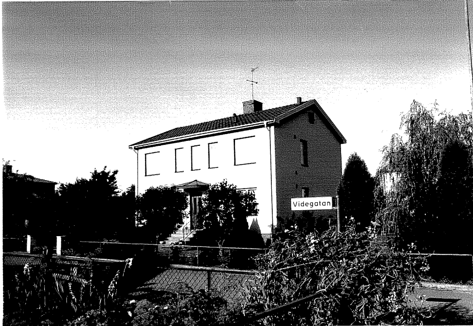
Neg. nr. V.T 02:31 Tvåfamiljshuset mot nordost
