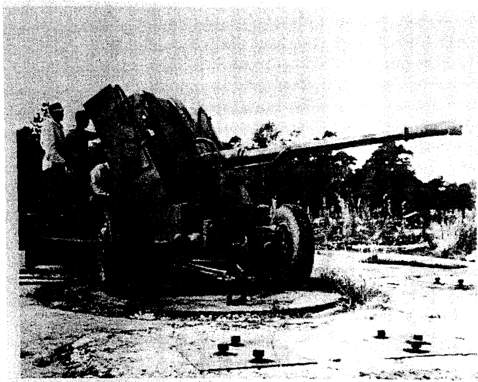
Ovan. 40 mm luftvärnsautomatkanon m/48. Denna pjäs hade hög eldhastighet 240 skott/min. Den kunde fjärrmanövreras. Med radarinstrumentering m m bildades system 48. Nedan 57 mm luftvärnsautomatkanon. Båda dessa pjästyper tillfördes Lvförbanden under 1950-talet och användes på Hästholmen.
