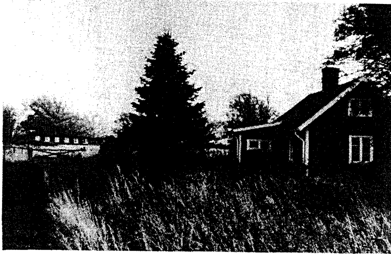
Torpet var tidigare under Stora Lund. Tidigt inrett till förläggning.
