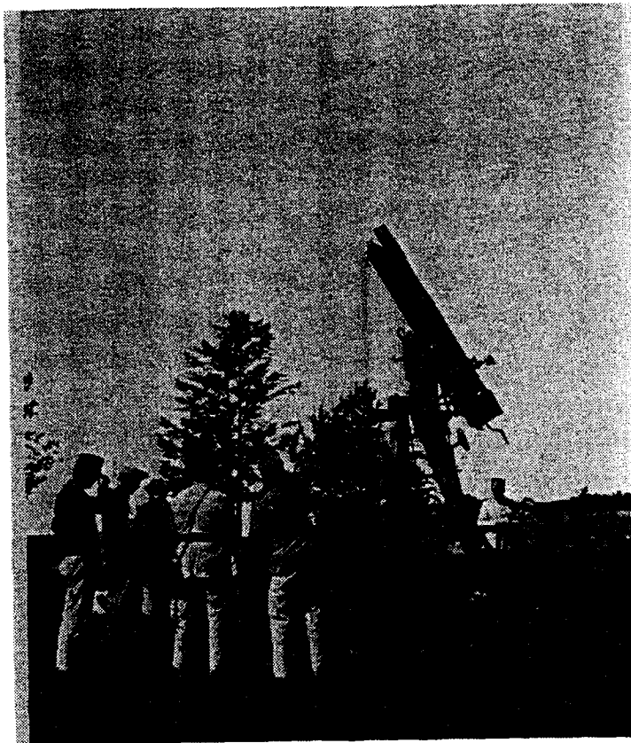
Luftvärnsförsök på Hästholmen 1926. Här en artilleripjäsa m/02 monterad på en i marken nedsatt trädstam.
