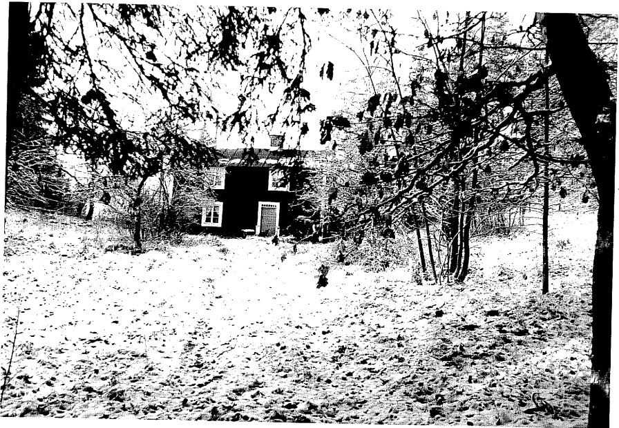
Neg. nr. T 08:23 Huset i miljön från SO
