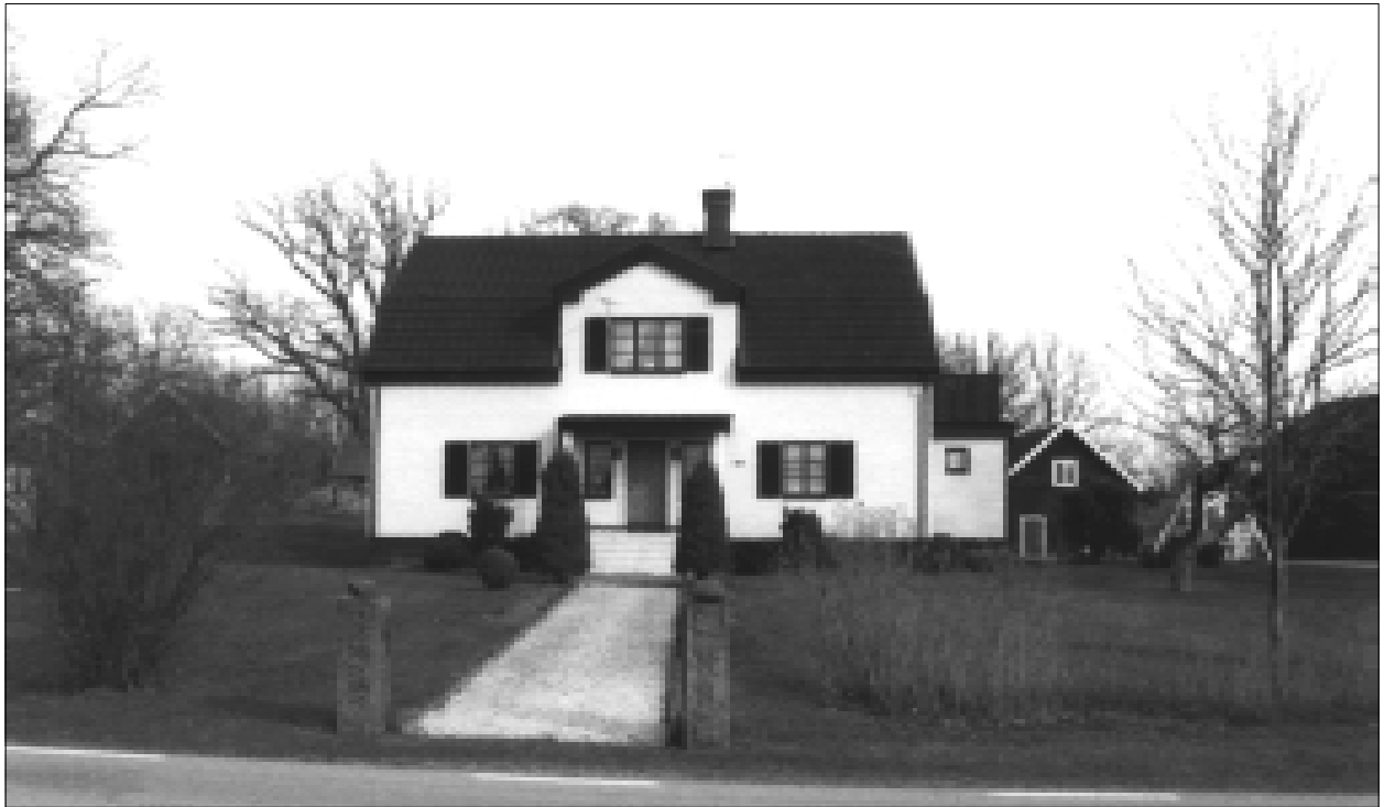
Mangårdsbyggnad från väster, Skrädeberg 1:3.
