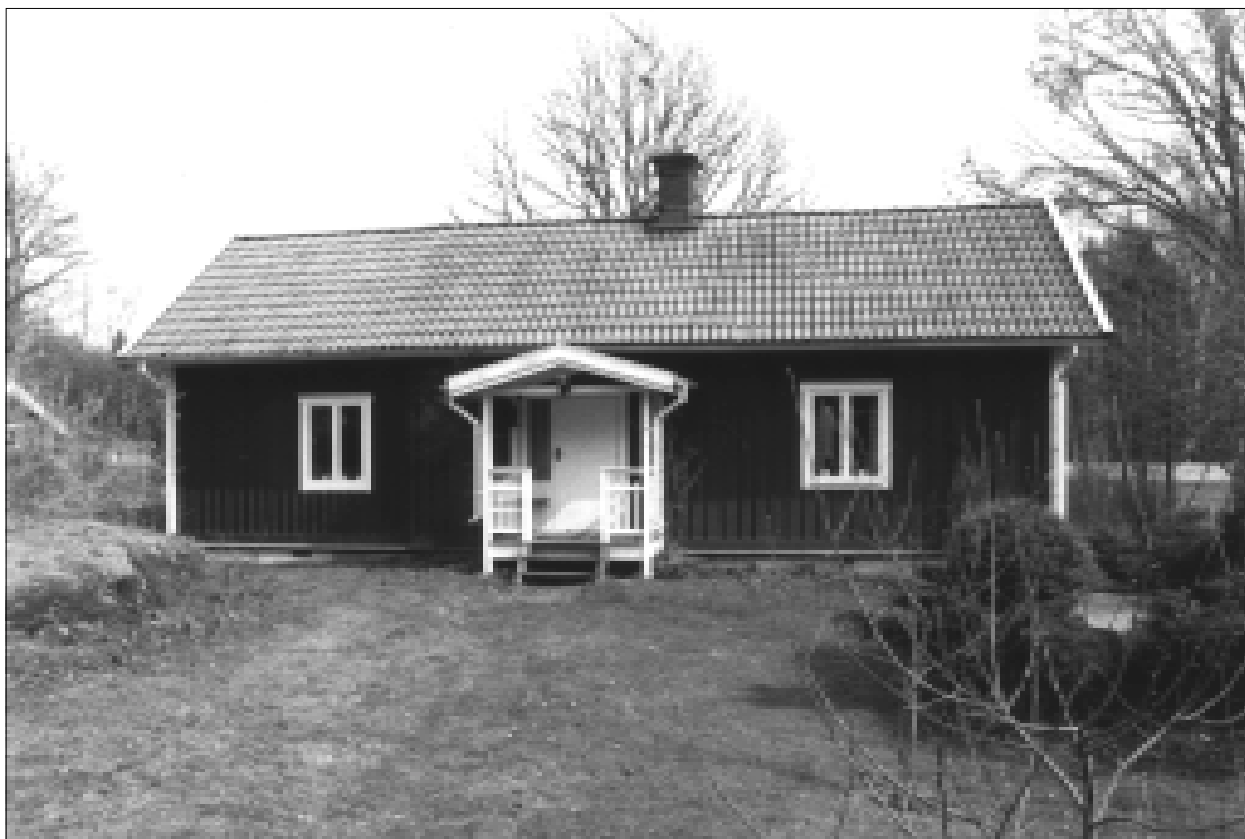
Mangårdsbyggnad från väster, Skrädeberg 1:9.
