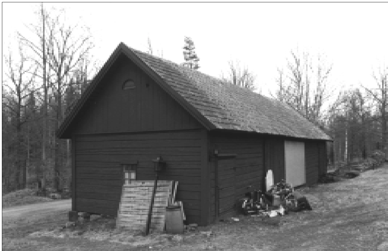
Före detta ladugård från nordväst, Stavreberg 1:15 område 2.
