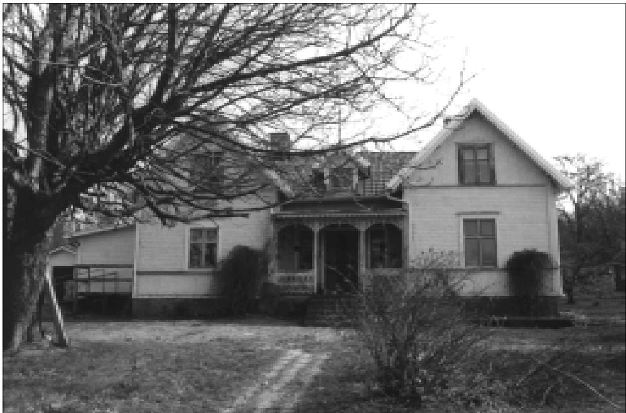
Mangårdsbyggnad från väst, Holkabergr 1:3.
