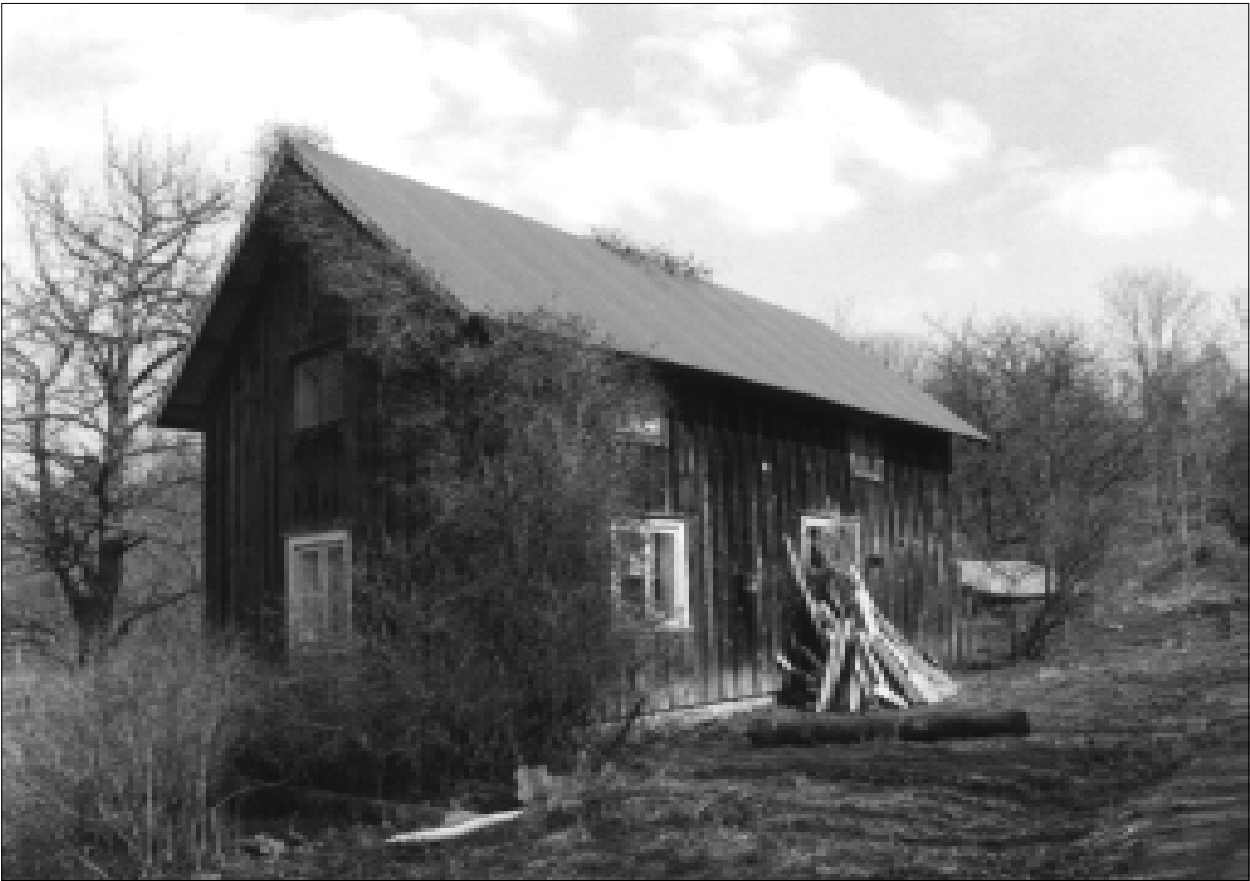
Flygelbyggnad från sydväst, Holkaberg 1:3.
