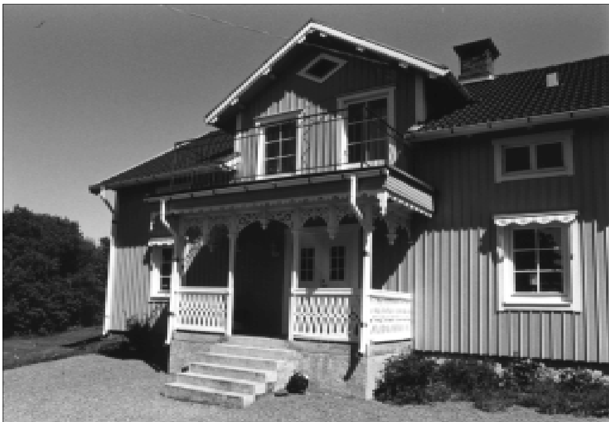
Mangårdsbyggnad från sydväst, Tingstad 1:4.
