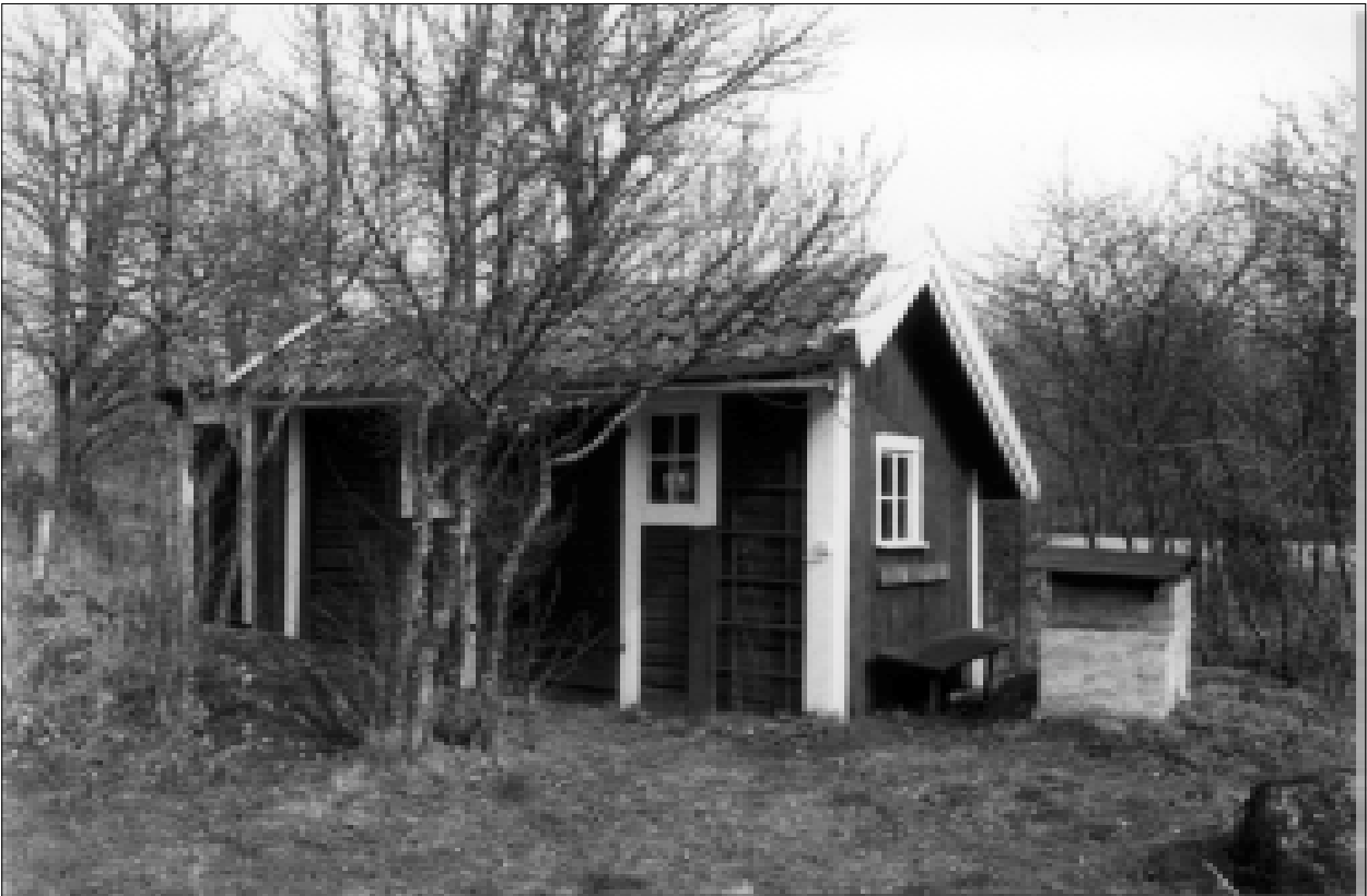
Före detta svin- och höns hus från väster, Skrädeberg 1:9.
