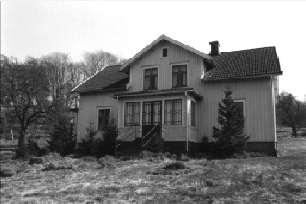
Mangårdsbyggnad från väst, Holkabergr 1:2.
