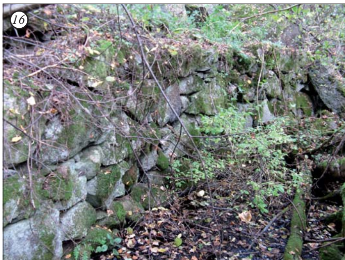
Figur 14. Två av de stenfundament som burit upp vattenrännan till hjulgraven. Foto mot sydväst.
